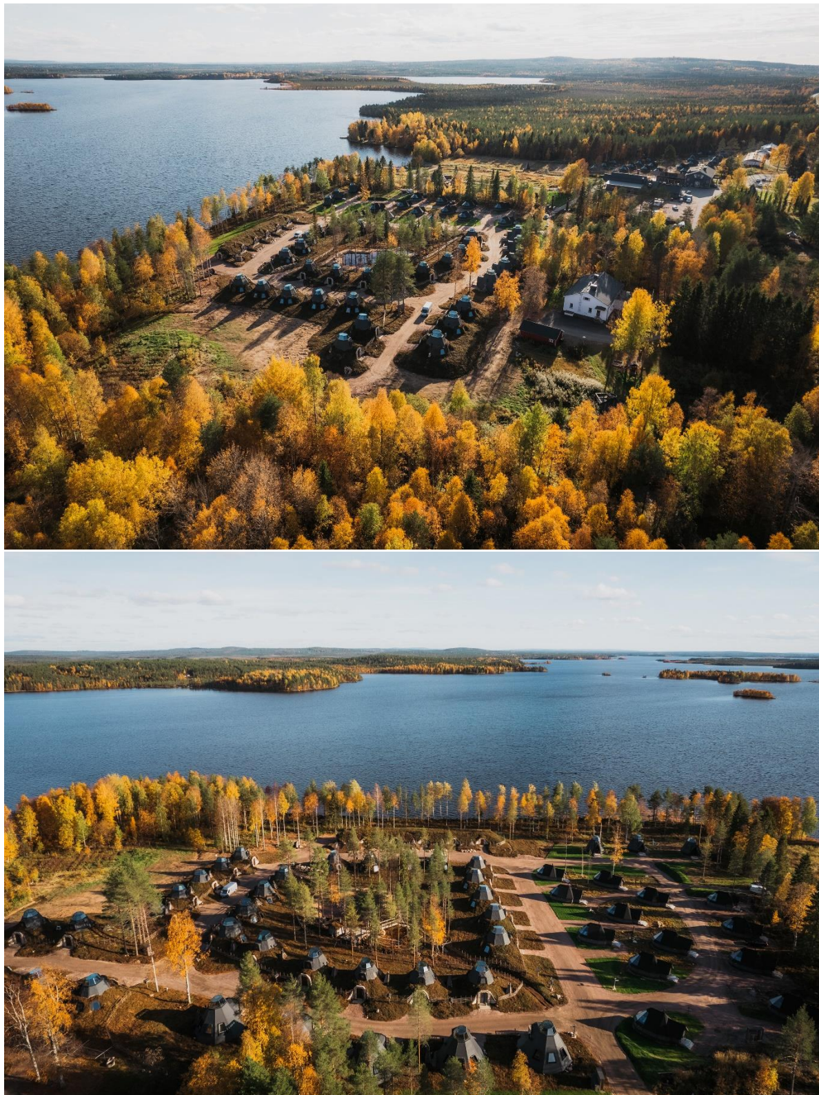
Kuva 13. Apukka Resortin rakennuksia VT 4 suunnalta.
